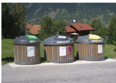
Une grappe de conteneurs semi-enterrés
